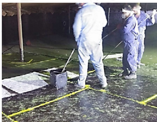
▲ اجرای پوشش کامپوزیتی در کف مخزن
